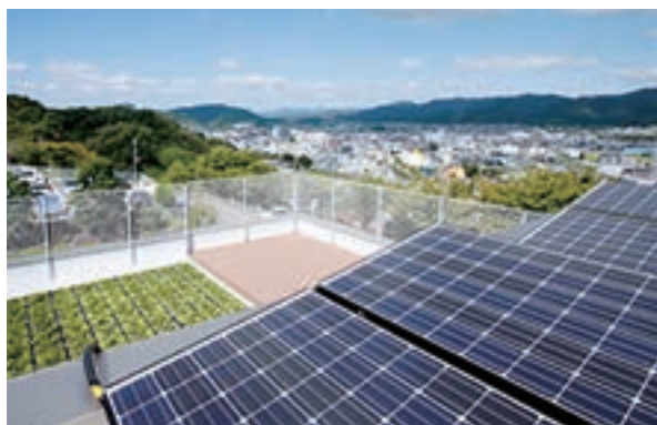
屋上の一部に太陽光発電パネルを設置
