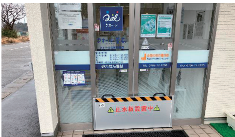
薬局入口への止水板設置
