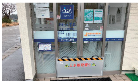
薬局入口への止水板設置
